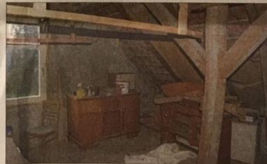
Das alte Ständerwerk von 1906 trägt auch heute noch das Dach des Wohn- und Geschäftshauses. Bild: Boelen
